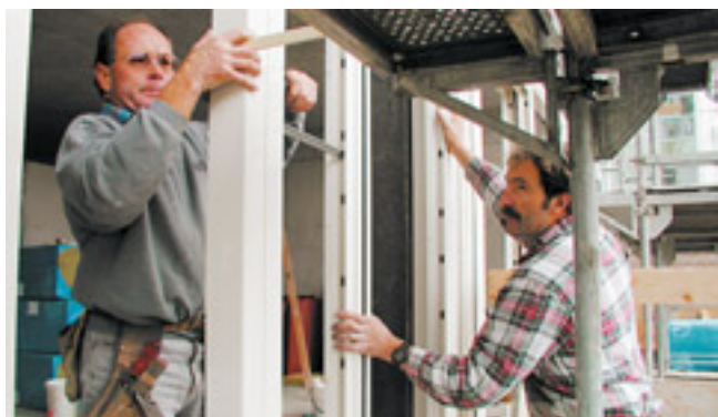
Sommer 2001: Das Innere des neuen Pflegezentrums nimmt Formen an: die Fenster werden eingebaut.
