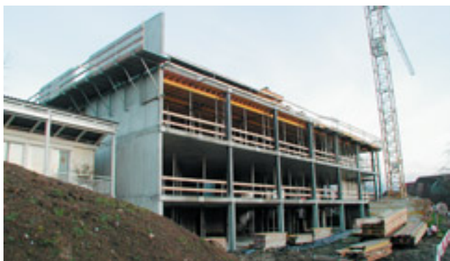
Ende Dezember 2000: Die Decke des zweiten Obergeschosses ist betoniert.
