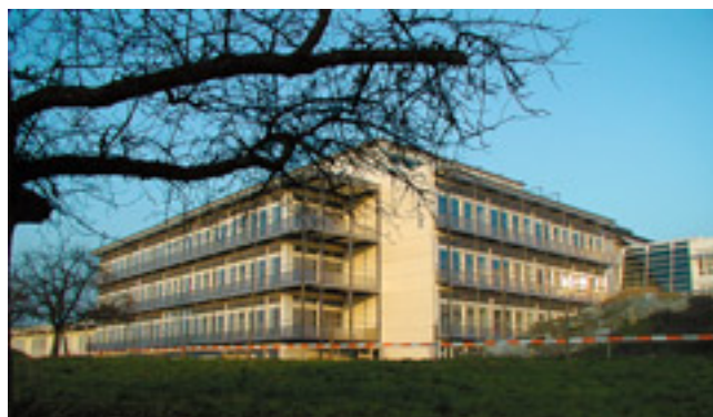
Dezember 2002: Das Aussengerüst ist entfernt – bis zur Fertigstellung verstreichen nur noch einige Monate!
