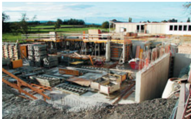
Anfang November 2000: Das Fundament ist gelegt, die ersten Mauern wachsen in die Höhe.
