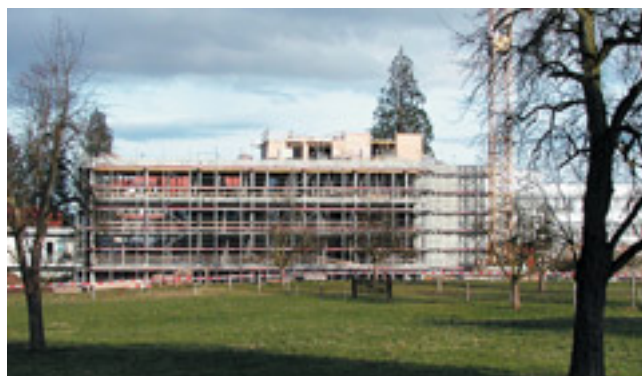
Februar 2001: Das milde Winterwetter hat den Fortschritt der Bauarbeiten begünstigt.
