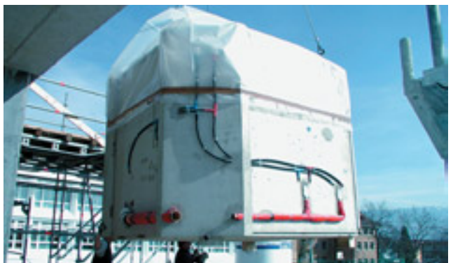
März 2001: Die Nasszellen werden fixfertig angeliefert, mit dem Kran gehoben und gleich eingebaut.
